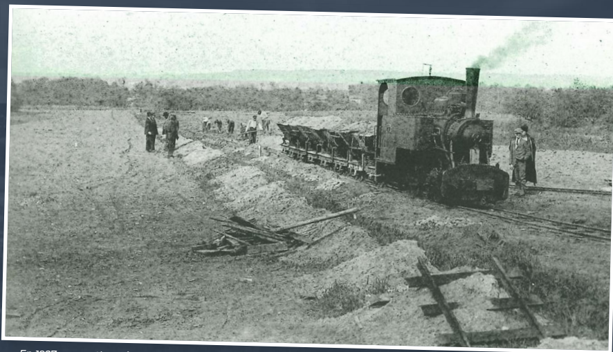
En 1927, une petite voie ferrée avait été installée au départ de la gare de Montigny-Beauchamp, en direction de la N14, pour permettre l'acheminement des matériaux de construction nécessaires à la création du lotissement (source : Histoire de Montigny-lès-Cormeilles, du village à la ville, 1800-1980, de Robert Hue).
