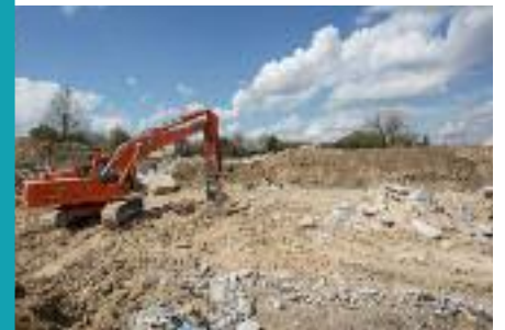
PREMIÈRE PHASE DES TRAVAUX DE LA ZAC DE LA GARE.
