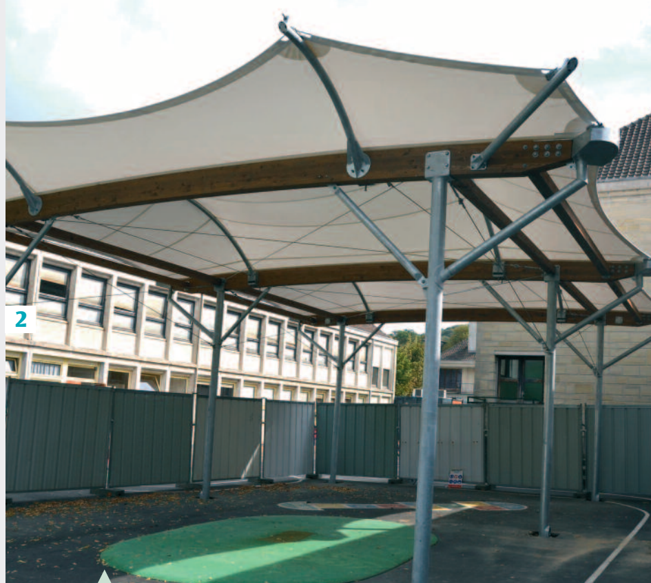
Les travaux sont quasiment finalisés, les élèves de l'école maternelle vont pouvoir jouer dehors malgré la pluie.
