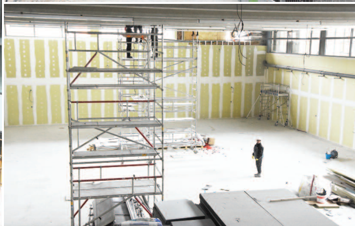
Le gymnase Lilian Thuram, en construction
