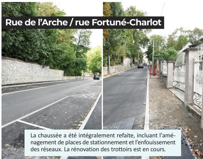
La chaussée a été intégralement refaite, incluant l'aménagement de places de stationnement et l'enfouissement des réseaux. La rénovation des trottoirs est en cours.
