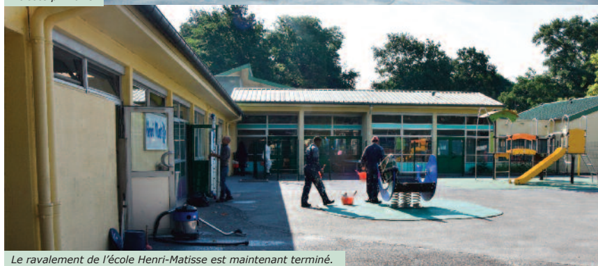
Le ravalement de l'école Henri-Matisse est maintenant terminé.
