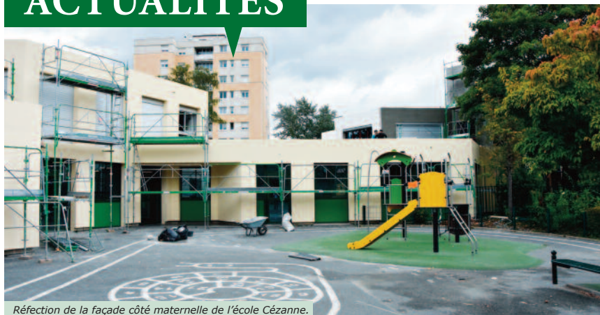
Réfection de la façade côté maternelle de l'école Cézanne.
