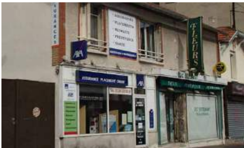
ENSEIGNES SANS LIEN AVEC LES FAÇADES - CORMEILLES-EN-PARISIS
