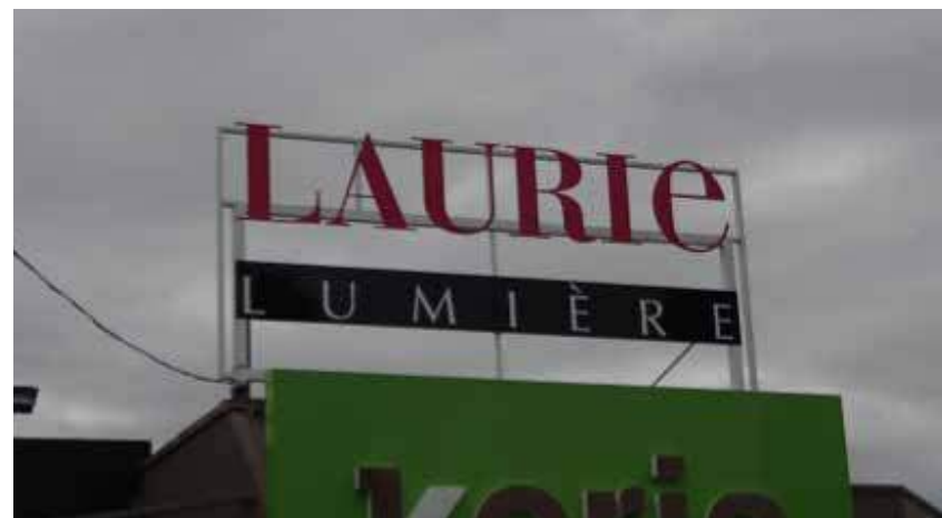
ENSEIGNE EN TOITURE AVEC LETTRES NON DÉCOUPÉES
