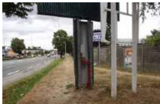
MAUVAIS ENTRETIEN TECHNIQUE
